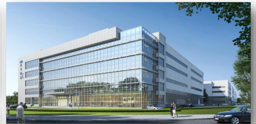
華眾當塗廠 建設中
